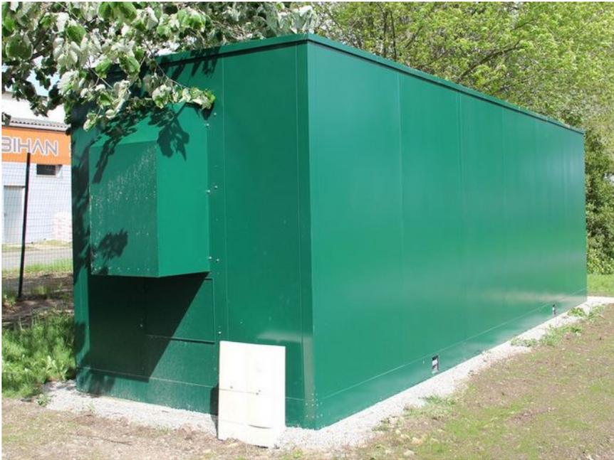
Au niveau local, c'est le premier maillon de la chaîne d'un réseau de fibre optique. C'est un local technique qui reçoit les infrastructures d'un opérateur. Un NRO abrite ce qu'on appelle un **OLT (Optical Line Terminal)** dont rôle est de faire le lien entre le réseau national optique et le réseau de distribution de chaque opérateur vers les abonnés.
